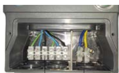
Connexion de la pompe et du projecteur
